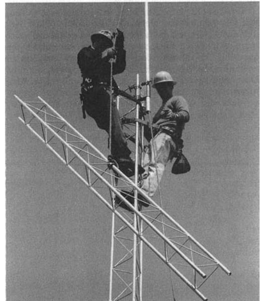
Die beiden obigen Bilder stammen aus dem ARRL Antenna Book und zeigen eine in den USA gebräuchliche und käufliche Art Gin Pole wie man ihn für Metallgittermaste (z.B. Versa Tower) einsetzt. Der Gin Pole lässt sich an einem der vertikalen Mastrohre anklemmen und beliebig positionieren.
