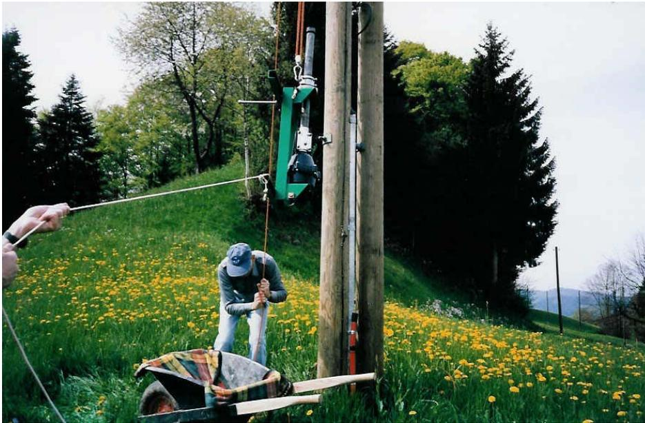
Hier eine selbst gebaute massive Rotorhalterung samt Oberlager, aufgenommen beim Aufzug auf den Mast. Es braucht nicht viel und der Rotor ist von den Seitenkräften befreit. Man glaube ja nicht das gelte nur für „grosse“ Beams. Auch kleine 3-Band Beams erzeugen schon ganz schöne Kräfte die auf den Rotor wirken. Auch hier gelten die Gesetze der Physik und Hebelarm ist halt nun einmal „Hebelarm“!
