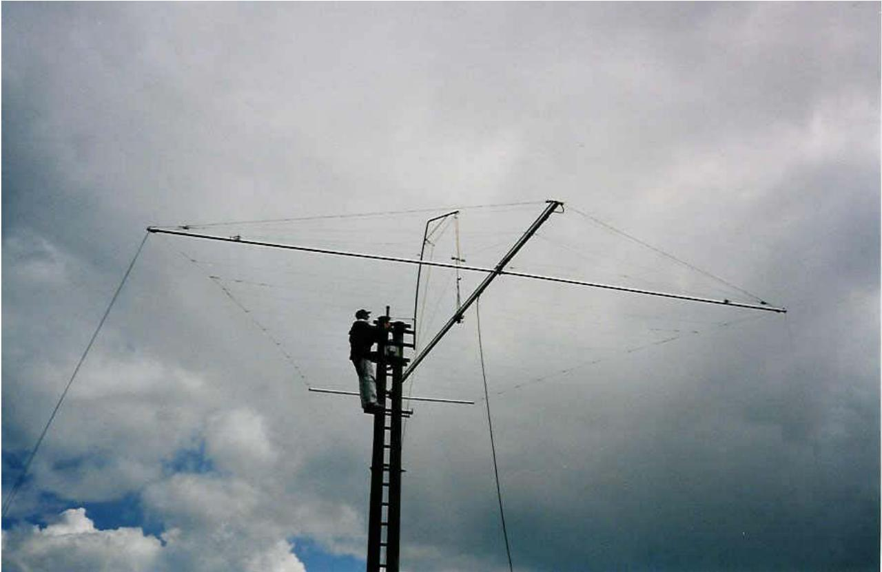
Amateurfunkantennen sind im allgemeinen so leicht wie nur irgendwie vertretbar gebaut. Wenn sich die Antenne am Boden befindet und man sie so schön im Schwerpunkt anfasst und hochhebt dann hat man noch bald einmal das Gefühl die Montage dieser Antenne sei keine Problem. Man kann die Antenne einfach halten und über das Befestigungsrohr, auch Standrohr genannt, schieben.
